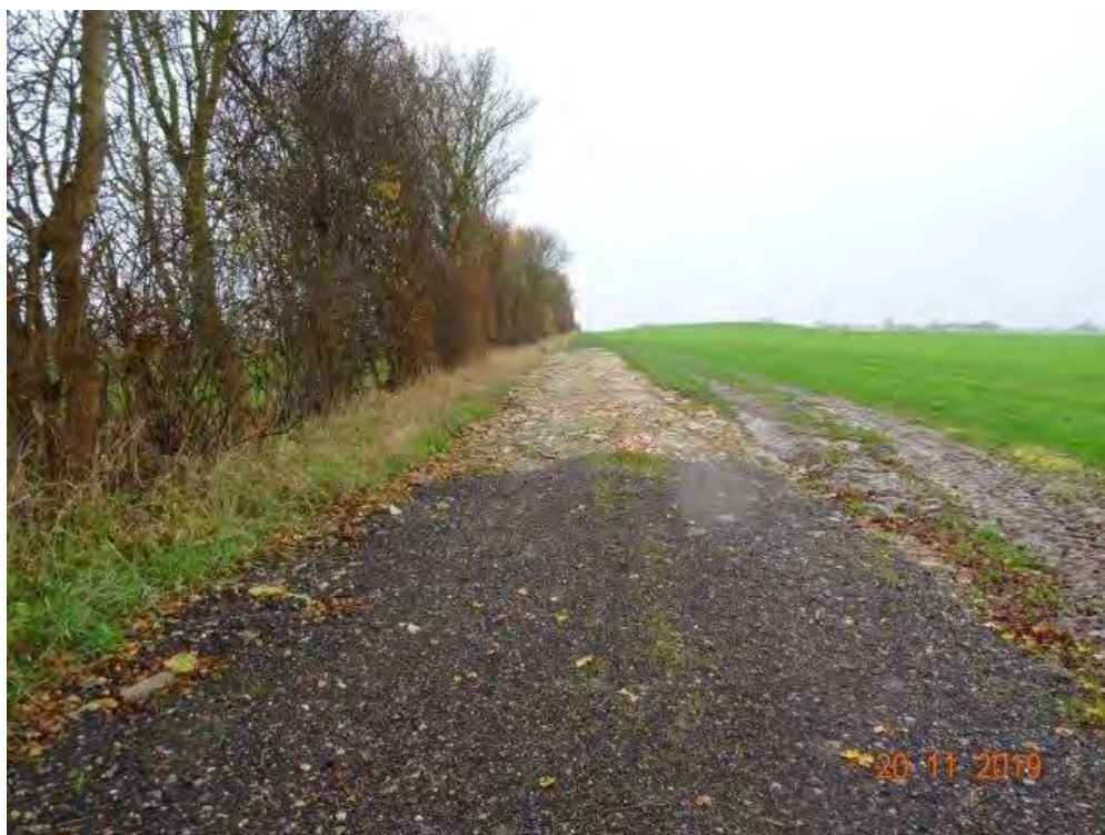
Knust asfalt udlagt på markvej vest for vandløbet Hederenden den 20. november 2019
