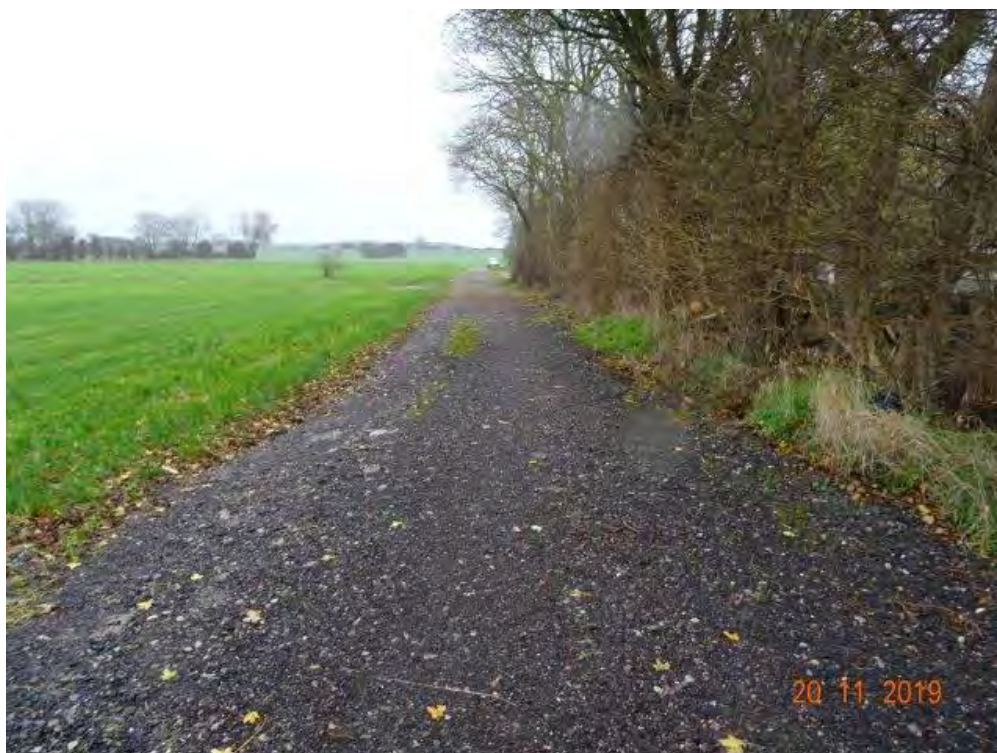
Foto. Knust asfalt udlagt på markvej vest for vandløbet Hederenden 20. november 2019. Ud for ejendommen Hedevejen 12.
