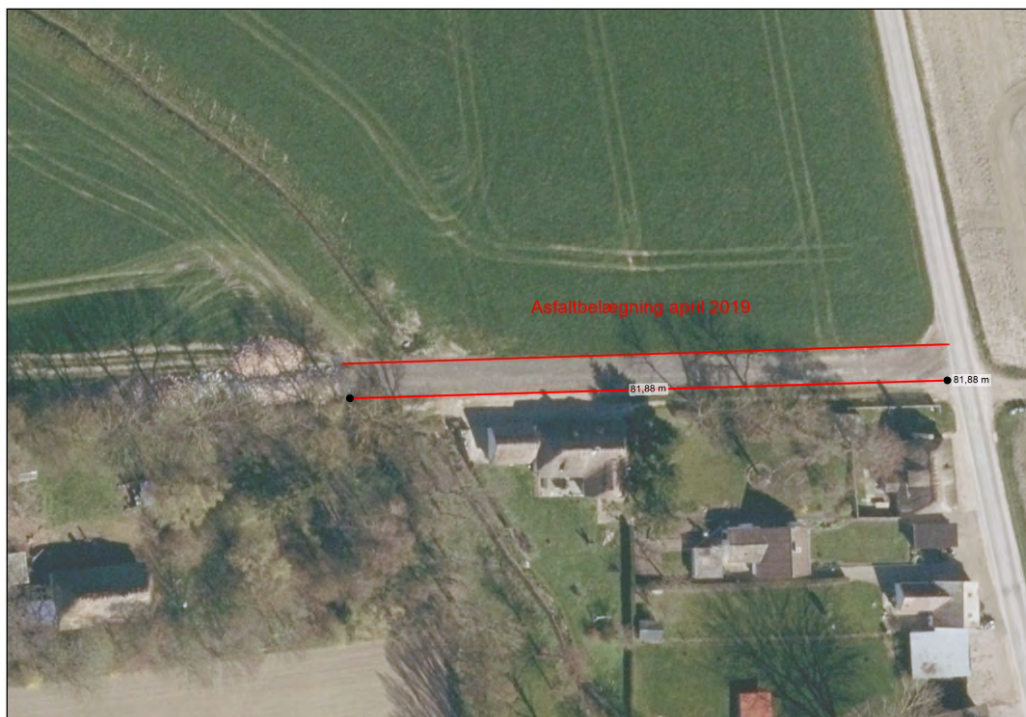
Belægning med knust asfalt på nyanlagt markvej nord for privat fællesvej og hen over ny overkørsel til vandløbet Hederenden (80 meter). Luftfoto april 2019.
