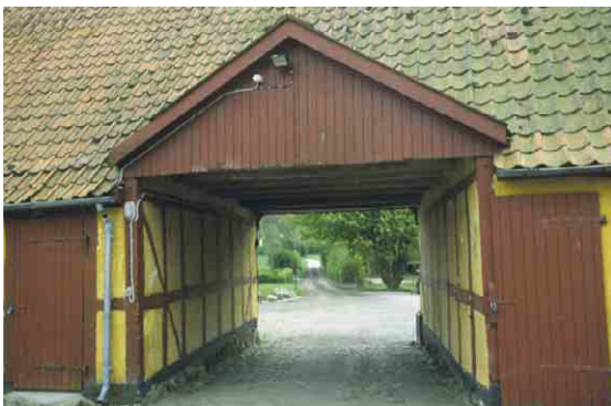
Portgennemskæringen i gårdens sydlige længebygning er markeret med en gavltrekan i taget.
