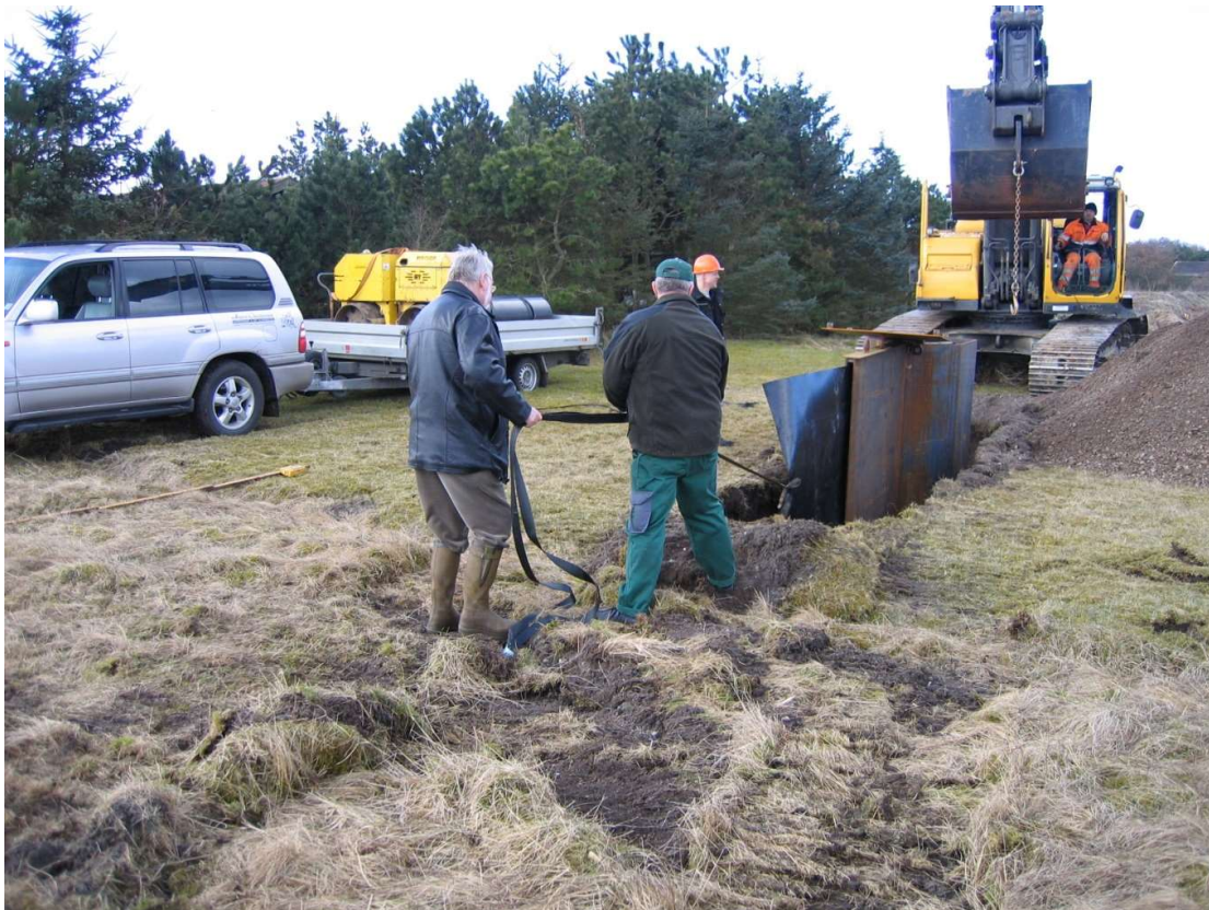
Figur 15 Fastholdelse af polymermembran, mens stålkassen trækkes frem i renden.
