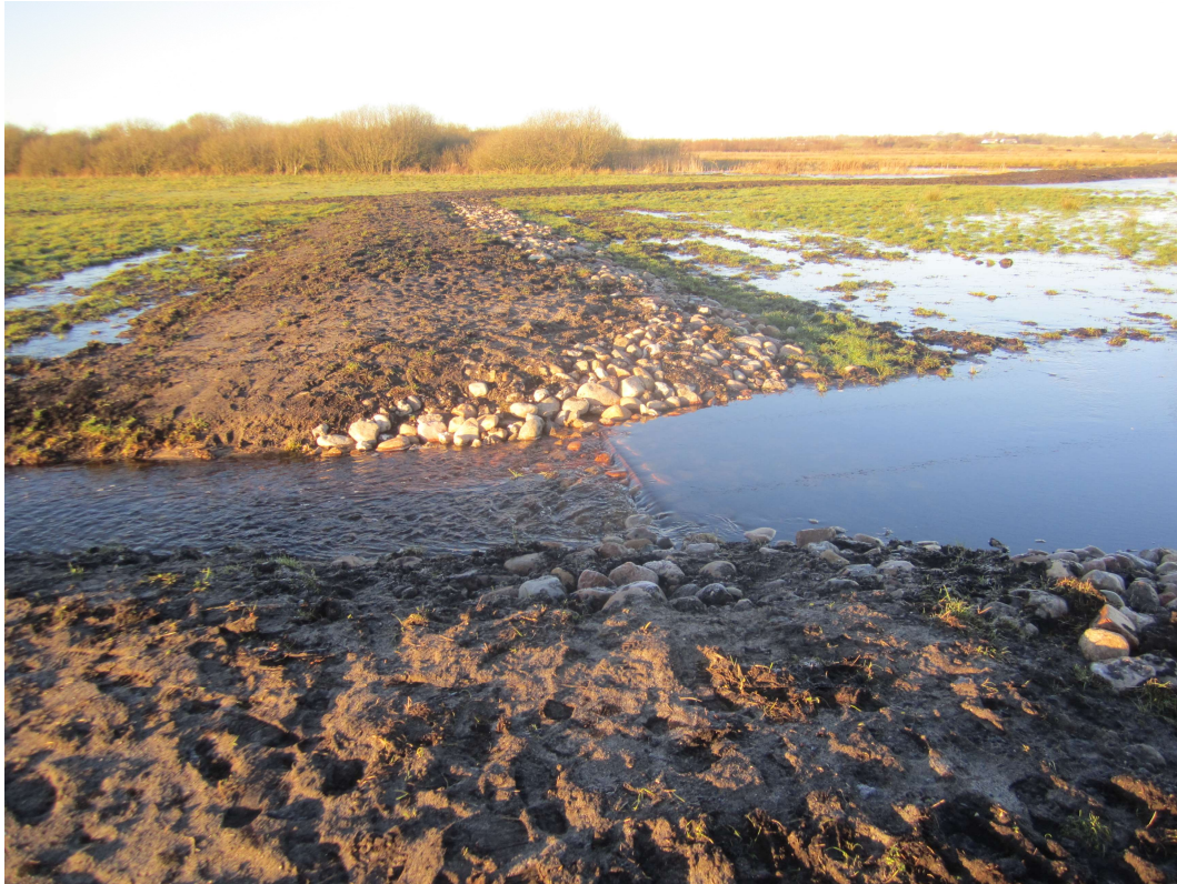
Figur 10 PE-plade etableret i udløb fra sø. Her dog med et fald henover PE-pladen
