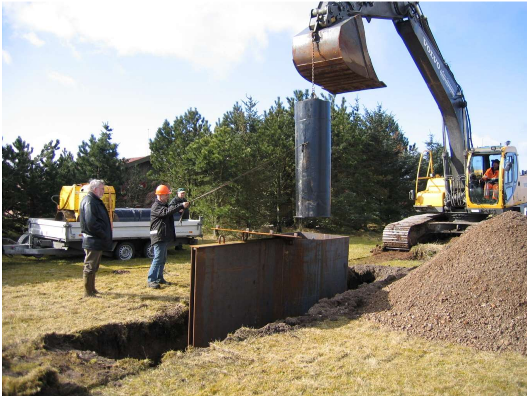
Figur 14 Placering af membranrulle i stålkasse
